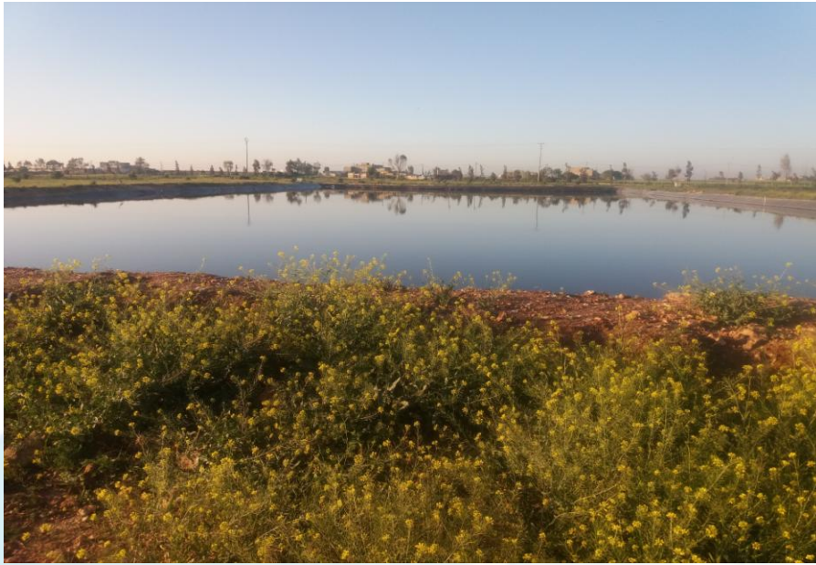
Lagune EST d'évaporation naturelle di lixiviat
