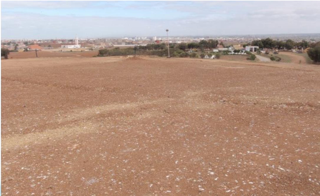
Dôme aménagé des casiers 1 ; 2 ; et 3.
