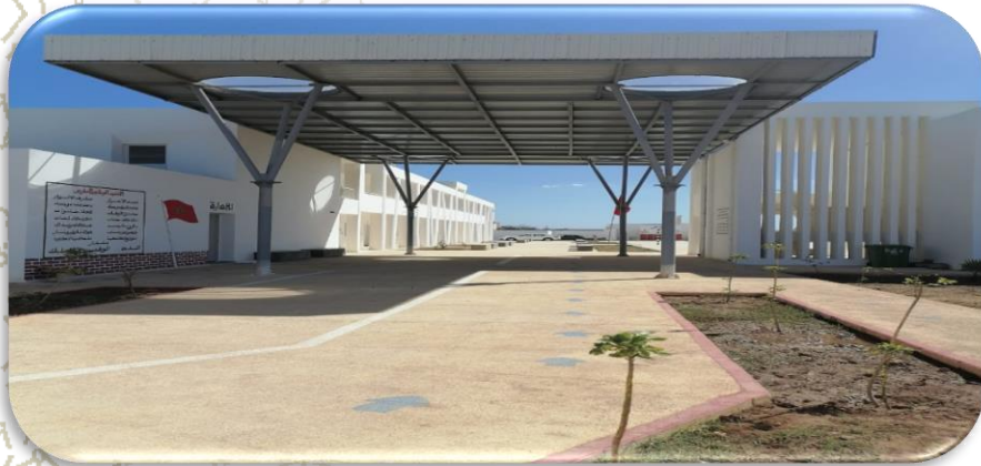
بناء إعدادية أولاد اسعد
