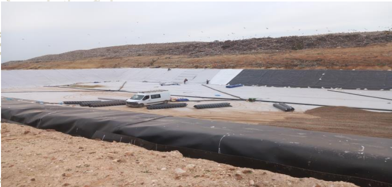
Mise en place du réseau de drainage
